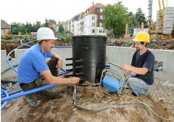
*Bild 9 - Die Kabel der Erdwärmeanlage waren am Verteiler montiert worden.*
