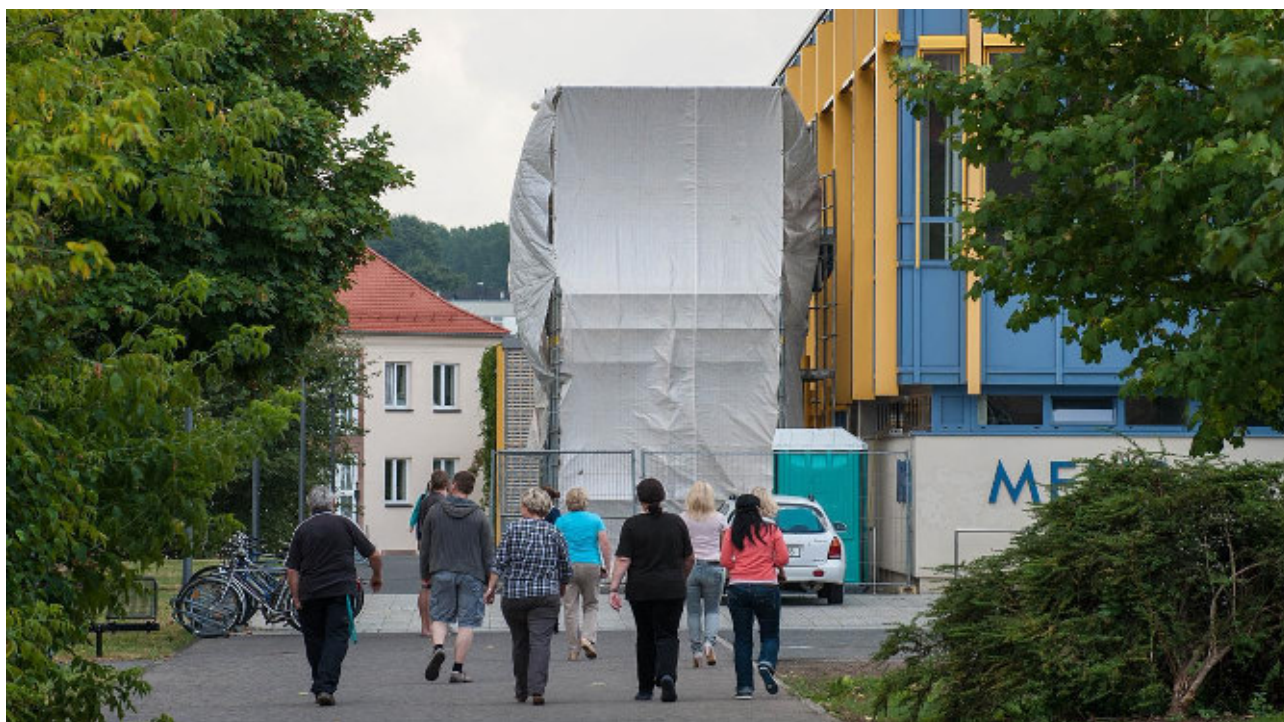
Bild 8: Während des Umbaus der Ausgabestrecke mussten einige Übergangslösungen geschaffen werden, wie z.B. dieser zusätzliche Fluchtweg. Aber der Aufwand hat sich gelohnt!
