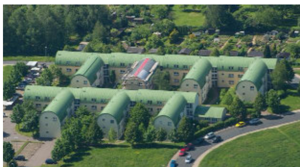
Bild 10: Stück für Stück werden die Dächer des Bereiches Prof.-Holzt-Straße erneuert, um die Baumängel endlich grundsätzlich zu beseitigen.
