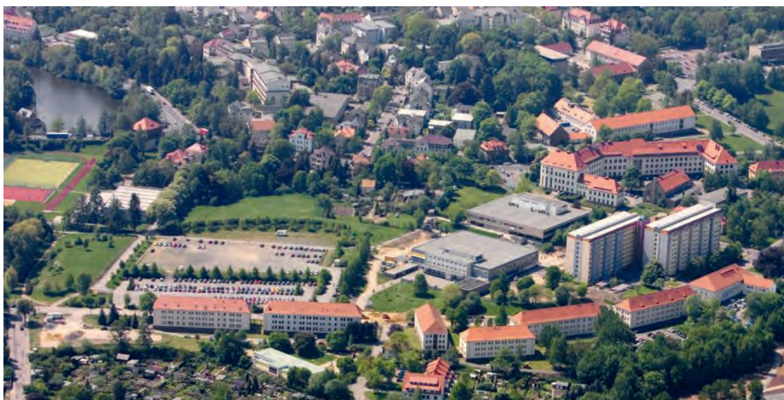
Luftansicht der Winklerstraße; alle Wohnheime auf dieser Straße mussten einer Ertüchtigung des Dachstuhls unterzogen werden
