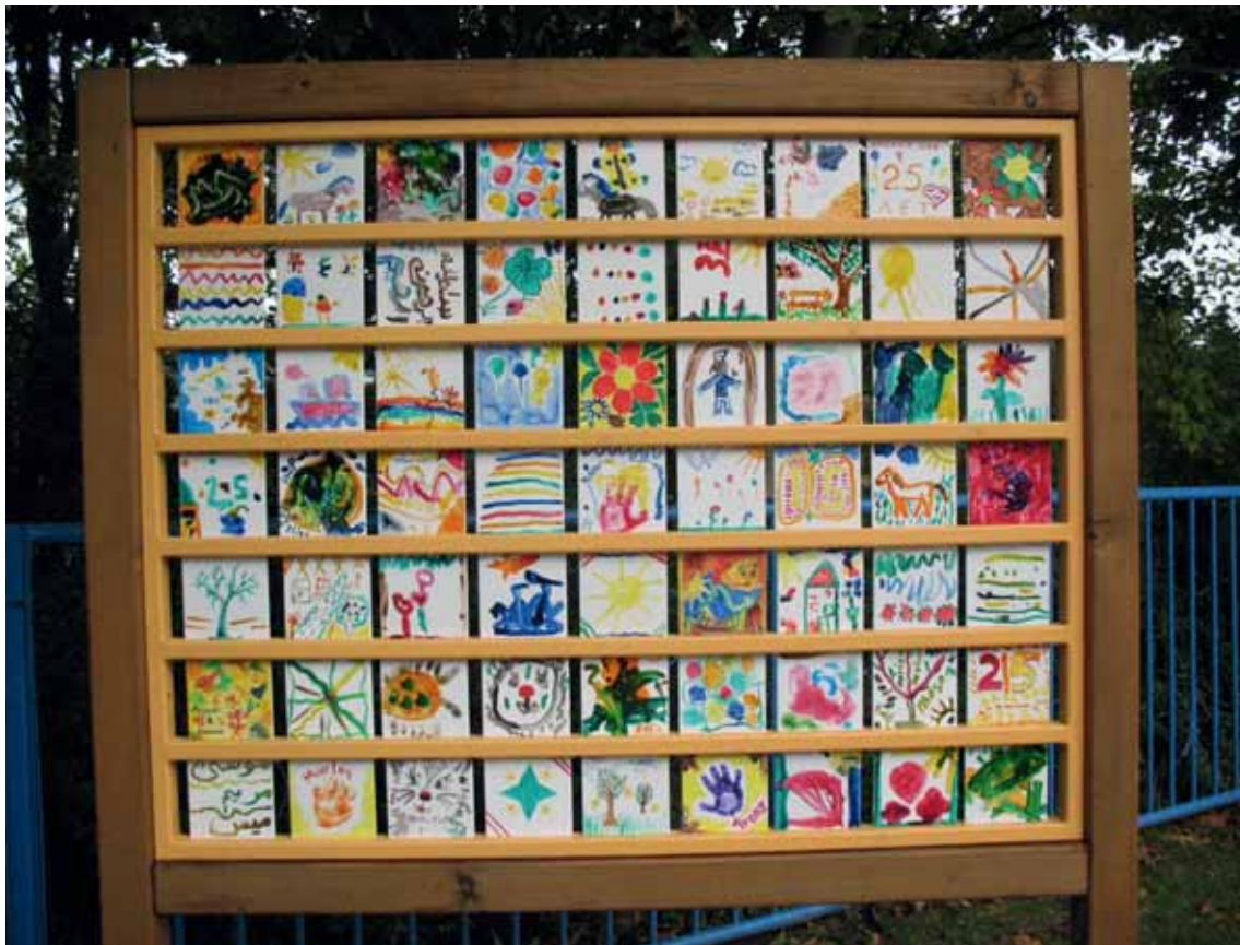
Sieht gar nicht so aufwendig aus, hat es aber in sich – der Holzrahmen für die Fliesenwand im Eingangsbereich der Kita Hornmühlenweg
