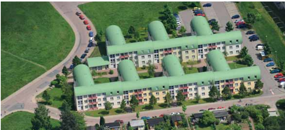
Nicht nur futuristisch, sondern mittlerweile auch problematisch – die Dachgestaltung der Wohnheime Prof.-Holzt-Straße
